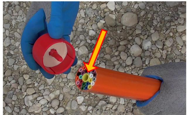
1.5 Zentrierdorn in das Zentralrohr einführen.
