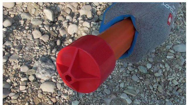
1.7 Fertig montierte Abdichtkappe.
