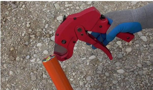
1.2 Für das Abschneiden des Endes vom Rohrverband, ein vom Hersteller empfohlenes Werkzeug verwenden.
