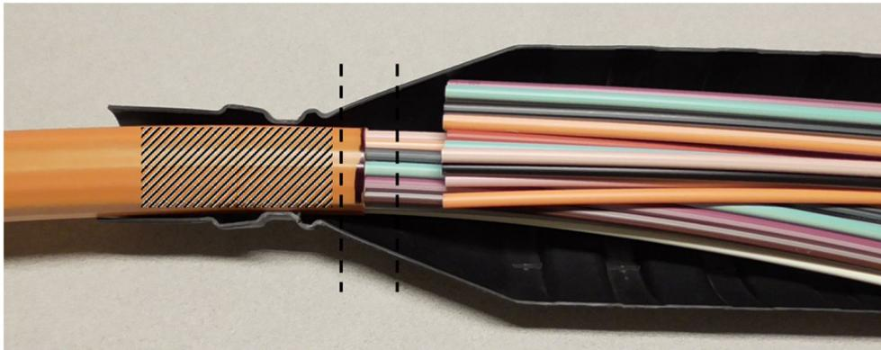
1.4 Die Rohrverbände wieder in die Unterschale einlegen. Die Absetzkante muss auf beiden Seiten im Bereich der Verjüngung in der Unterschale liegen (Striche). Der Mantel des Rohrverbands muss im Bereich der Zugabfangung (schraffierter Bereich) sauber und frei von Verschmutzung sein.
