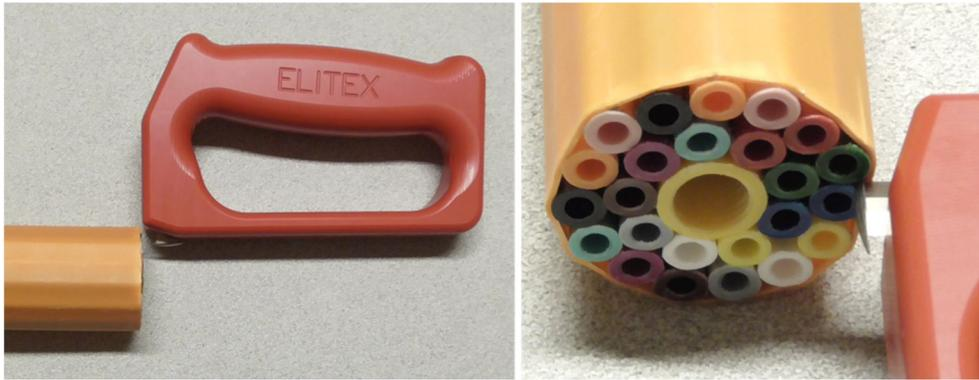
1.3 Rohrverbund bis zur Markierung abmanteln. Werkzeug nach Vorgabe des Herstellers vom Rohrverband verwenden. Zum Abmanteln kann auch das Elitex Abmantelwerkzeug verwendet werden.
